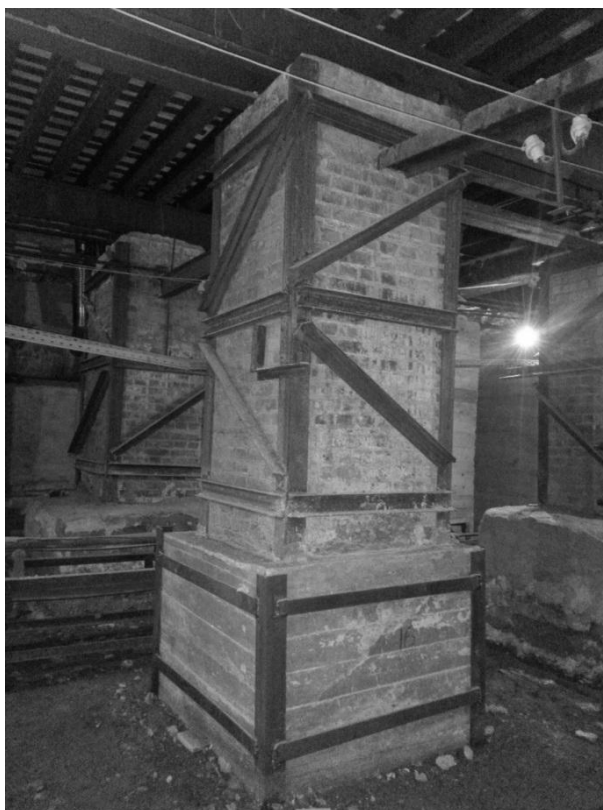
Рис. 1. Общий вид опоры
