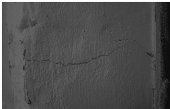
*Рис. 2. Трещины в штукатурке цоколя*
