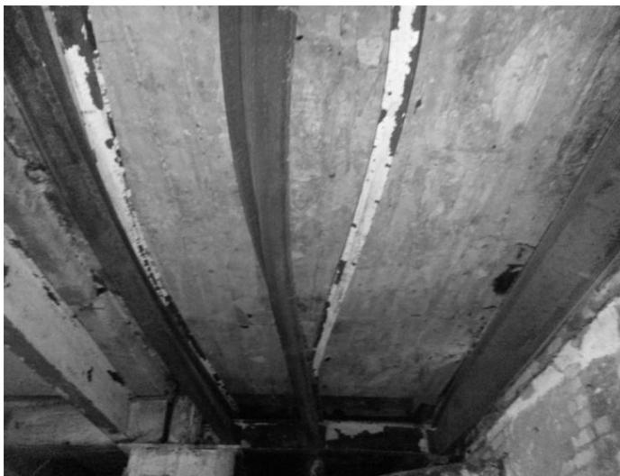
*Рис. 2. Перекрытия в месте пожара, потеря устойчивости и выгибы металлических балок*
