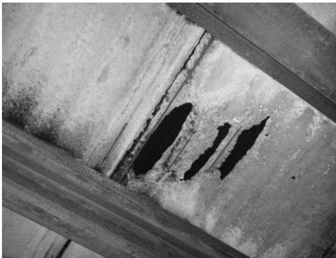
*Рис. 1. Прогоревшие плиты перекрытия, разрушение бетона*
