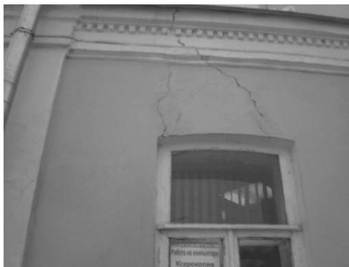
*Рис. 1. Разрушение облицовочного слоя здания*
