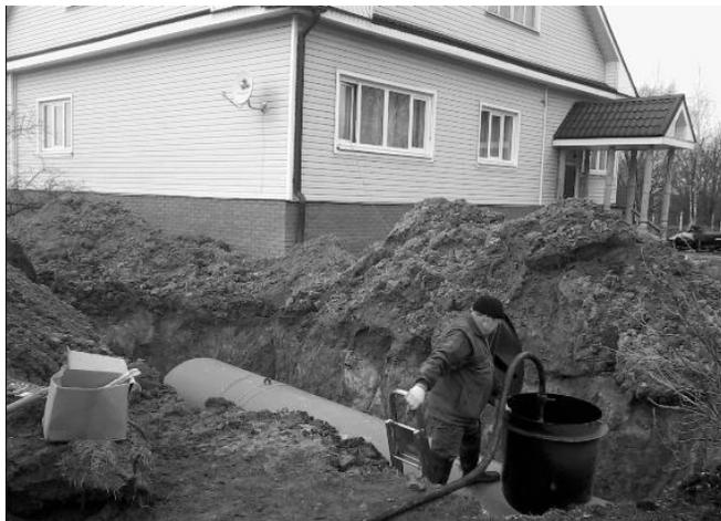
*Рис. 1. Газгольдер частного дома*
