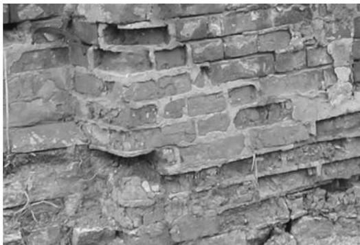
*Рис. 3. Деструкция наружного слоя кладки*
