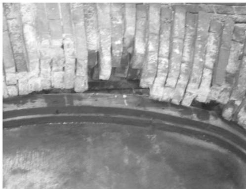
*Рис. 1. Разрушение клинчатой перемычки*
