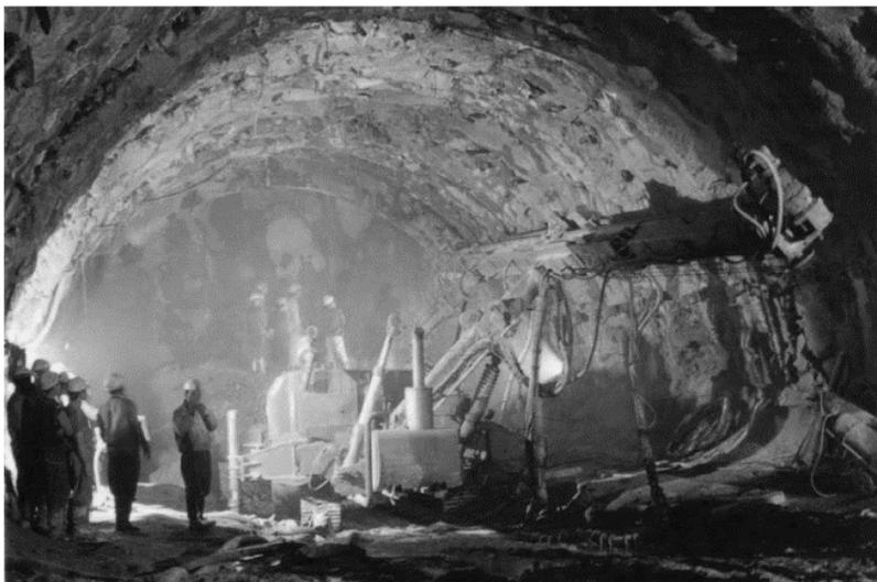
Фото 1. Установка труб, длиной 12 м и диаметром 75 мм в нарушенную кровлю тоннеля
