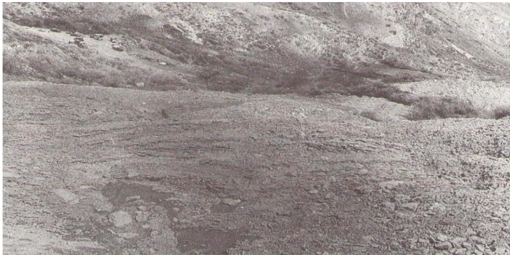
Рис. 1. Оползень на 58 км автодороги Душанбе – Куляб, перевал Шар – Шар, вид сверху
